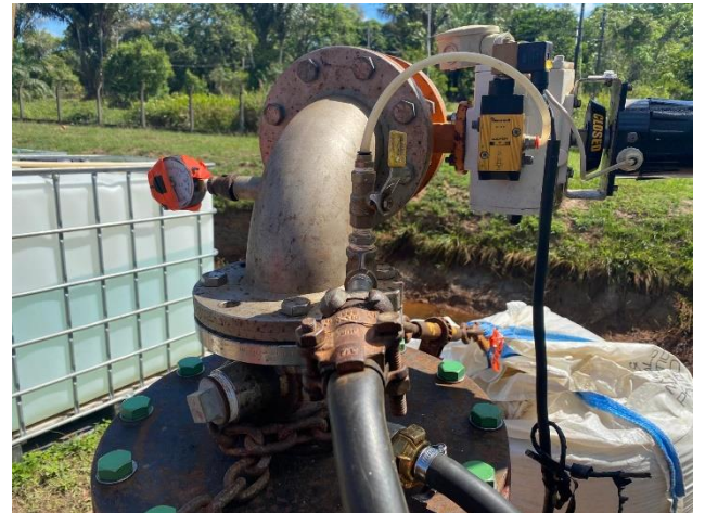
Kopplaat met drukmeter en afsluiter voor het jutteren
