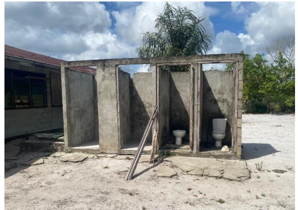
Renovatie en uitbreiding toiletten
