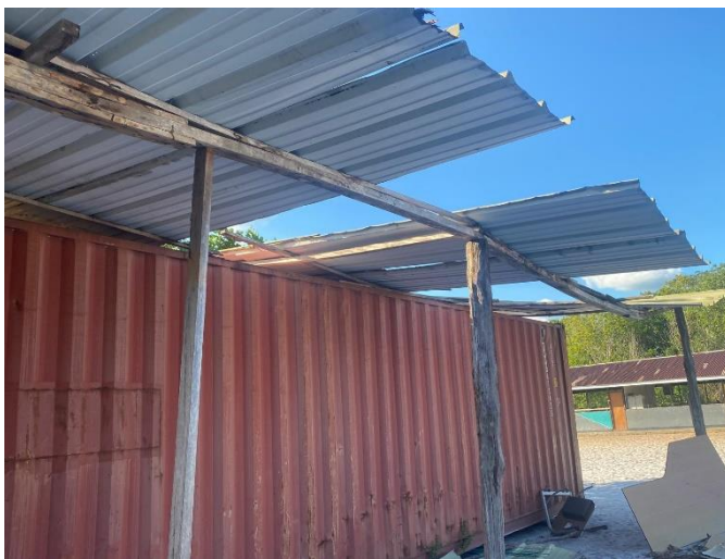
Dak van de container
